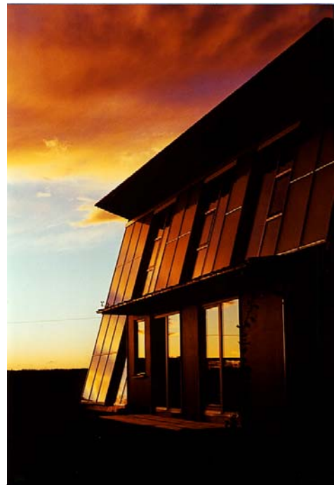
Abbildung 4: Solarfassade als gestalterisches Element.
