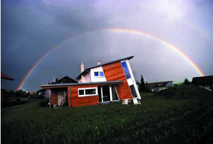
Westansicht; Fassade mit Lärcheschalung; begrüntes Flach- und Pultdach
