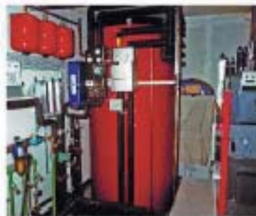
Im Heizraum steht ein Holzvergaserkessel mit 14kW Leistung
