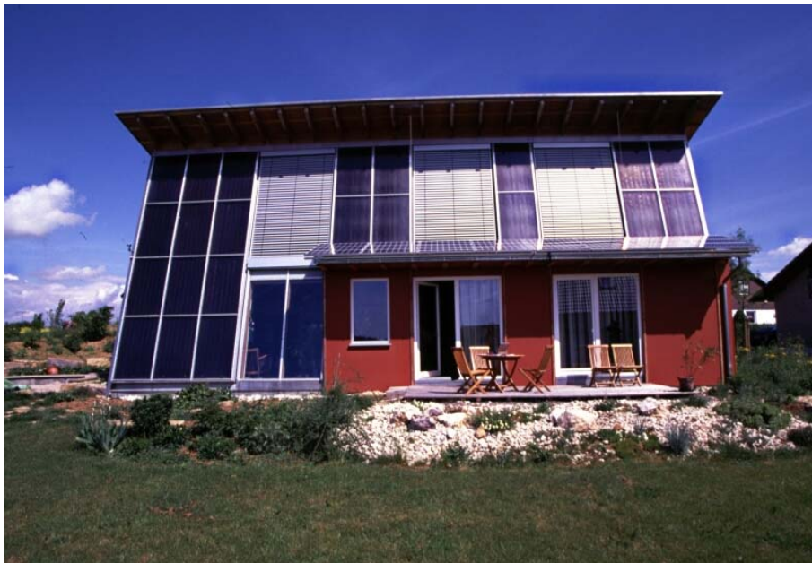
Graphik: Solares Bauen, Solaroffice Seeborn; rein regenerativ beheiztes Gebäude mit einem Restwärmebedarf von 9,5 \text{ kWh/m}^2\text{a} einschl. Warmwasser Quelle: ECONSULT, www.solaroffice.de
